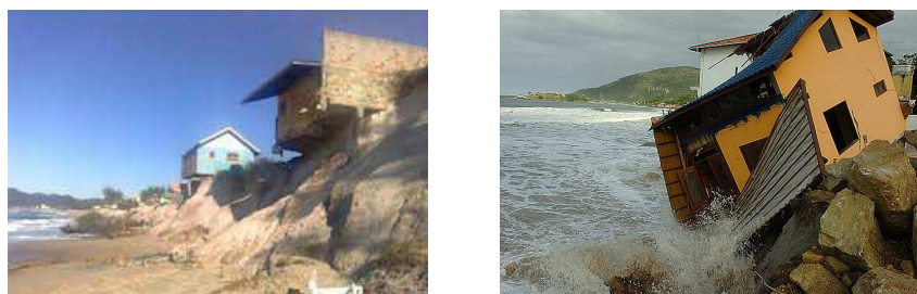
Figura 1: Destruição ocorrida na praia da Armação durante eventos extremos ocorridos em 2010, Florianópolis, Santa Catarina, Brasil.
