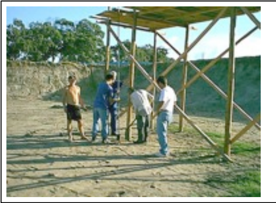
Figura 7. Colocação das placas de recalque
