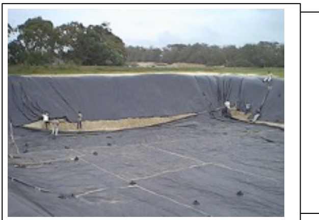
Figura 5. Impermeabilização da bacia
