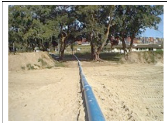
9. Tubulação de lançamento
