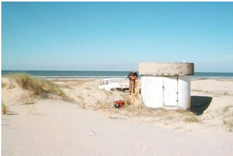
Figura 05 – Casa de bombas da EMA – Praia do Cassino - Rio Grande - RS
