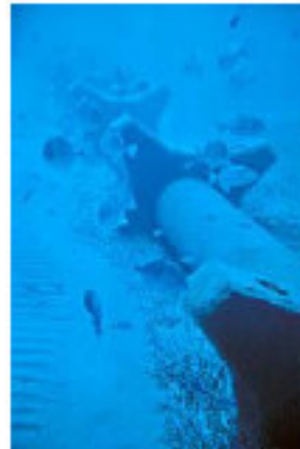
Figura 3: Foto mostrando parte de um gasoduto já instalado. Fonte: Sanchez, [8].
