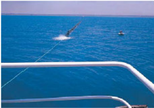
Figura 2: Transporte em superfície de tubos para a construção de um gasoduto. Fonte: Sanchez, [8].
